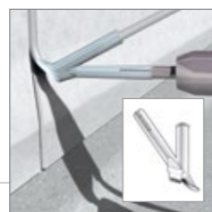
Soudure murale parfaite avec cordon CR40 0585
